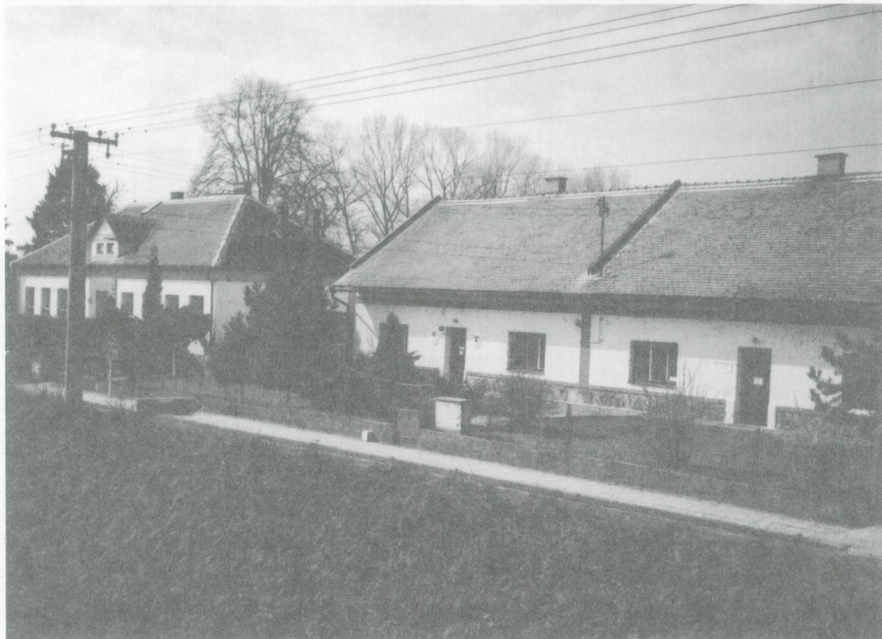
Budova obecního úřadu a mateřské školy.
