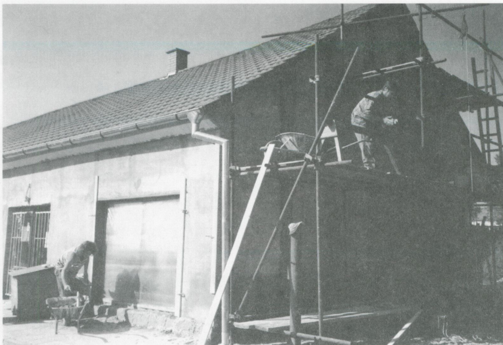
Oprava obecní prodejny čp. 36 v roce 2000.
